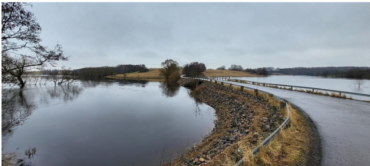
Pinnåns utlopp (pkt58) i Rönne å, vid höglöddessituation i februari 2024.
