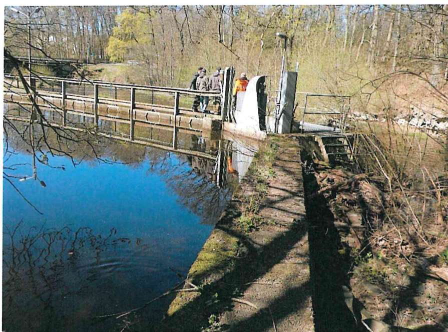
Figur 5. Från höger till vänster: höger betongdamm, höger flodutskov och överfallsdamm mellan flodutskoven. Nedströmsvy över dammbyggnaden från höger landfäste (foto: Rejlers).
