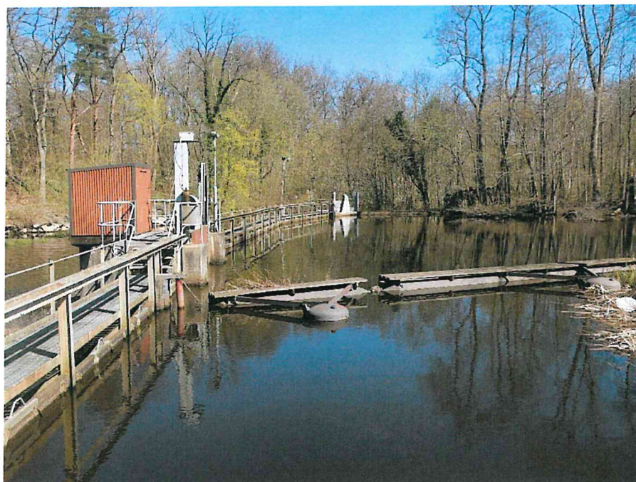
Figur 7. Från höger till vänster: höger flodutskov, överfallsdamm, vänster flodutskov och vänster överfallsdamm. Ytläns till höger i förgrunden. Vy längs med dammbyggnaden från intagskanalen (foto: Rejlers).
