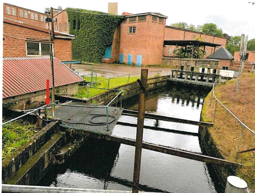
Figur 8. Intagskanalen med vy nedströms från bro vid Bruksallén. Processvattenintag till vänster (rött pil), avstängningsluckor, intag och kraftstation i bakgrunden.
