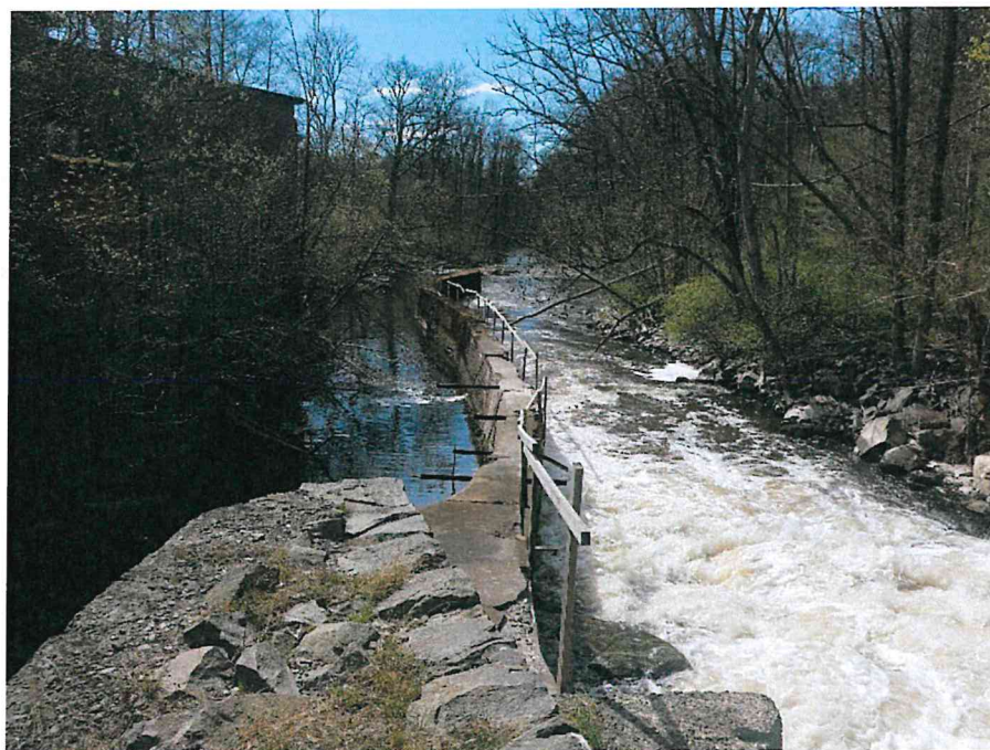
Figur 9. Nedströmsvy över naturfåra och utloppskanal. Foto: Rejlers.
