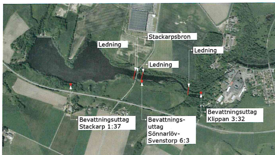
Figur 11. Bevattningsuttag, bro och ledningar i det indämda vattenområdet.
