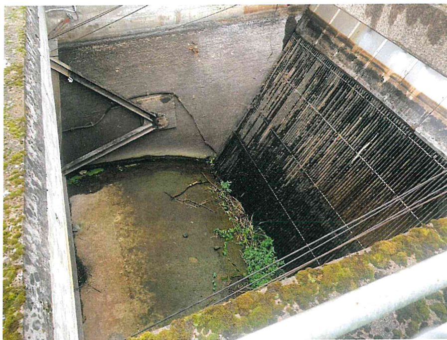
Figur 6. Torrlagd intagskanal. Segmentlucka syns till vänster i bild.
