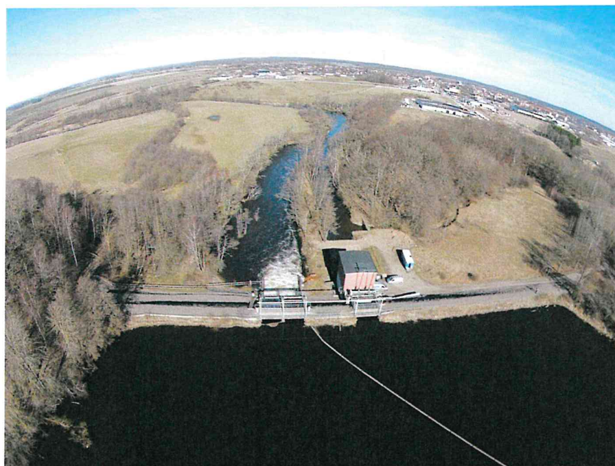
Figur 3. Nedströmsvy över anläggningen från dammen.
