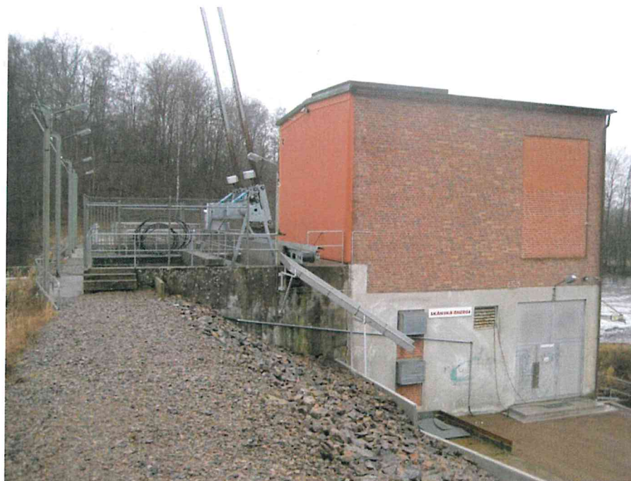
Figur 7. Kraftstation och intag från dammens högra landfäste.
